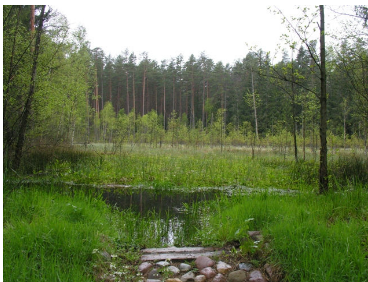
Ryc. 38 Próg z bystrotokiem ( fot. A. Ryś)
