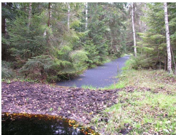
Ryc. 34. Przetamowanie ziemne na rowie( fot. A. Ryś)
