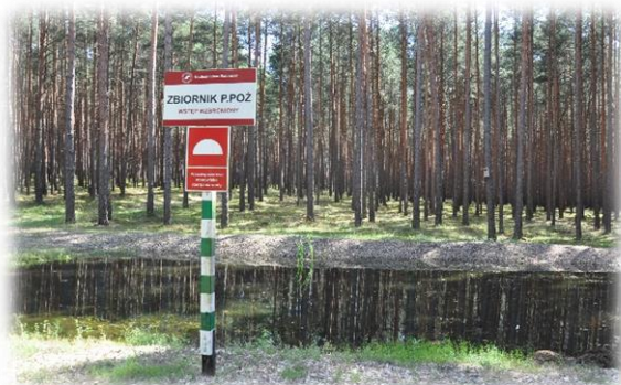
Fot. 124. Zbiornik przeciwpożarowy (fot. B. Iwaniuk)
