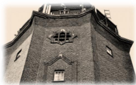
Fot. 93. Zabytkowa wieża ciśnień w Zbąszynku ( www.lwkz.pl )
