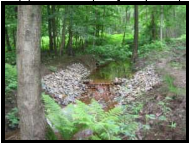
Ryc. 47. Zastawka kamienna (przetamowanie) na rowie w Leśnictwie Baszkowo, oddz. 133b – fot. Autor
