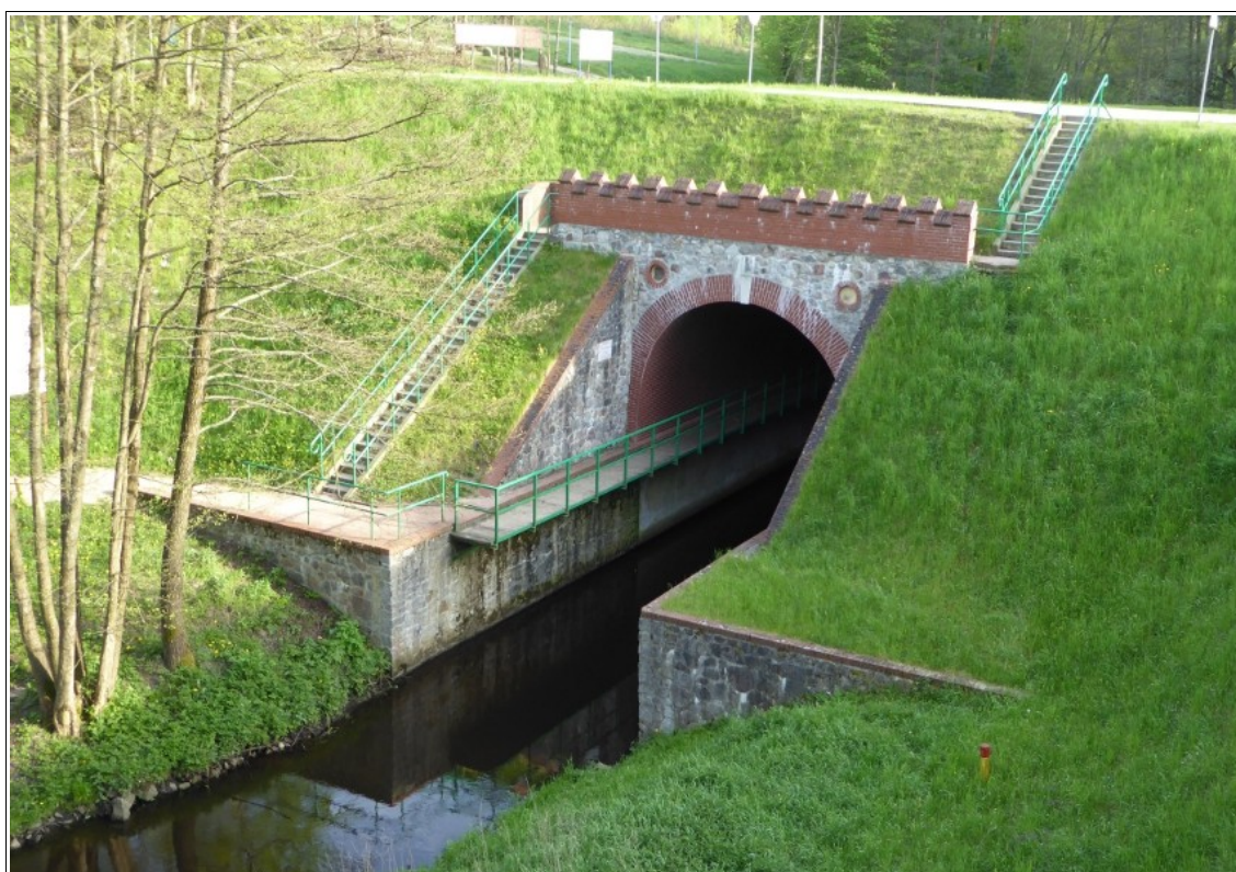
Fotografia nr 13. Akwedukt Fojutowo
