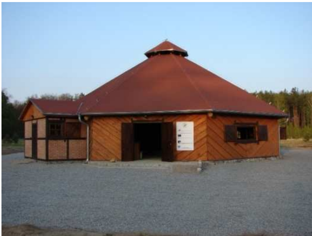
LEŚNE CENTRUM EKOLOGICZNE w Dankowie – widok z zewnątrz
