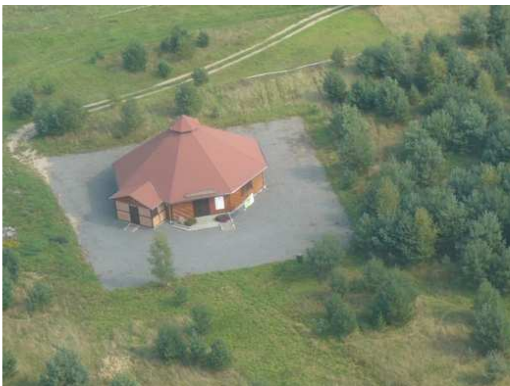
LEŚNE CENTRUM EKOLOGICZNE w Dankowie – widok z lotu ptaka
