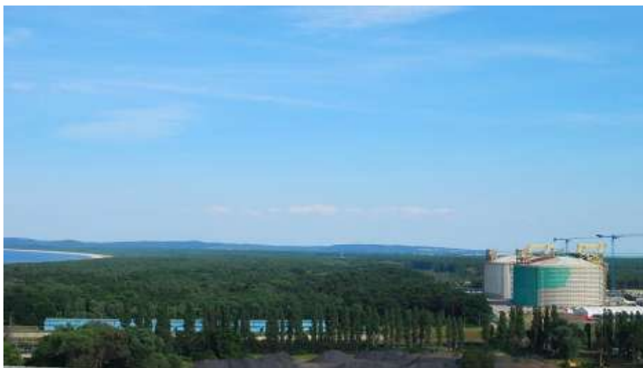
Fot. 17 Terminal gazowy w Świnoujściu (fot. Dariusz Wawrzak).
