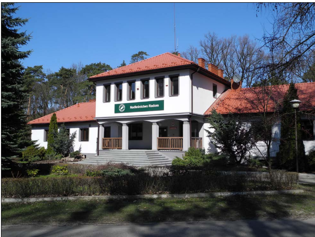
Fot. 1. Siedziba biura Nadleśnictwa Radom
