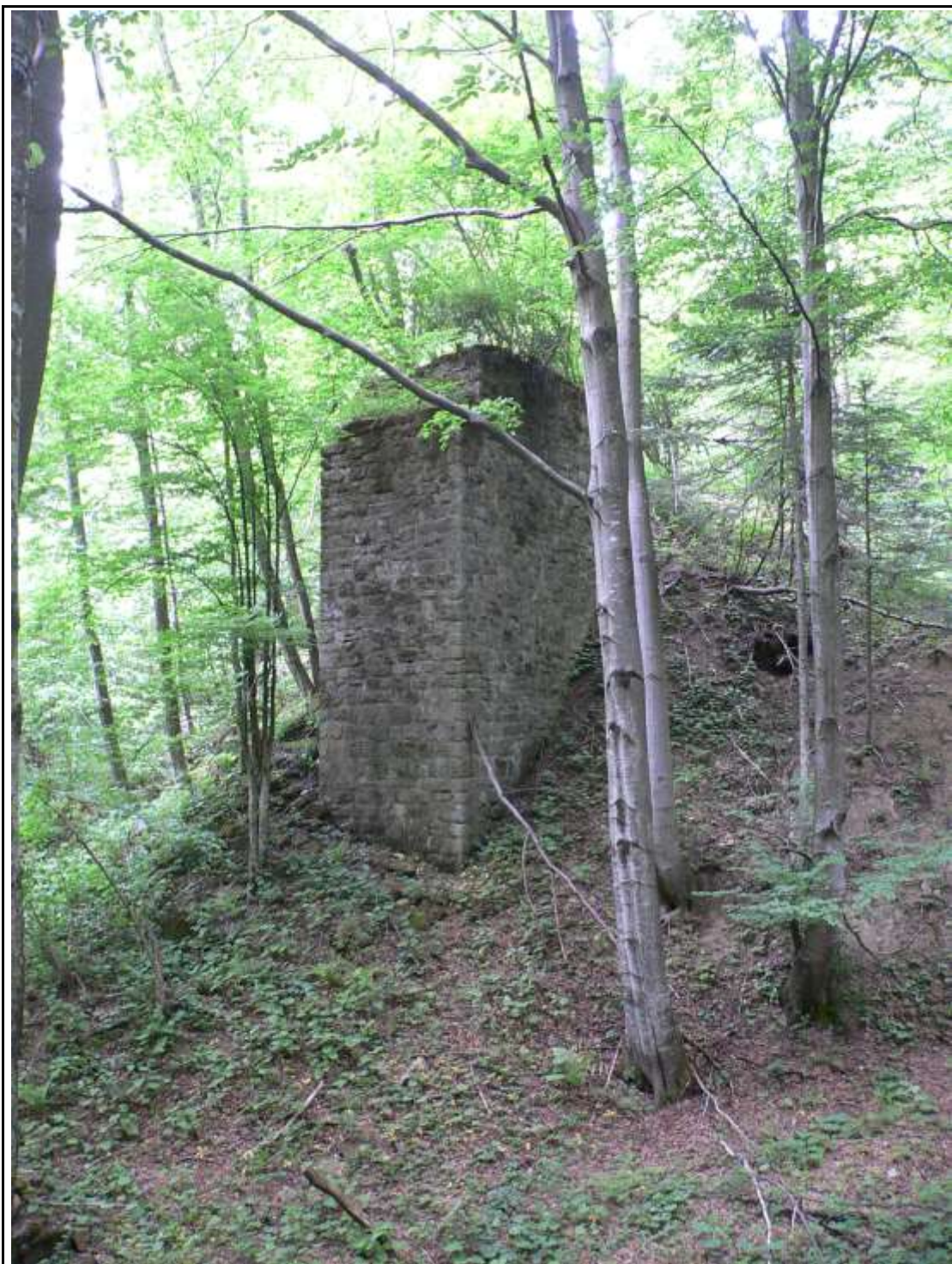
Fot. 5 Filar mostu kolejki (oddz. 21a).
