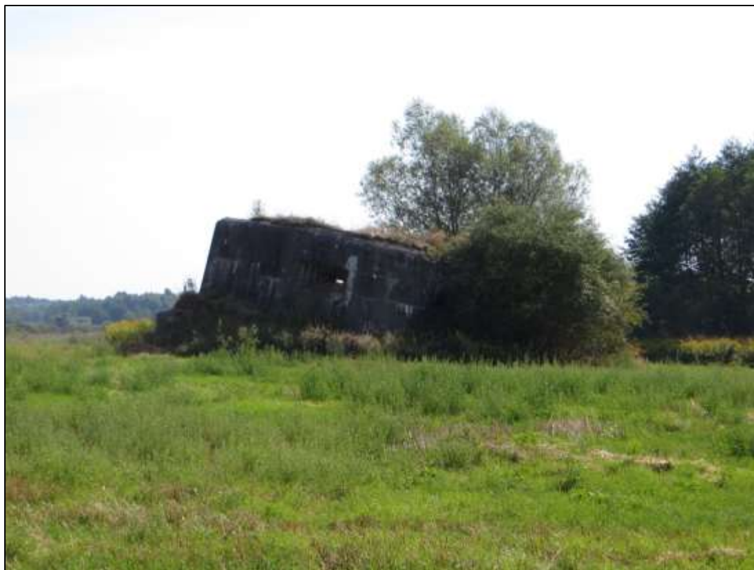
Bunkier znajdujący się w zasięgu administracyjnym leśnictwa Dąbrowa
