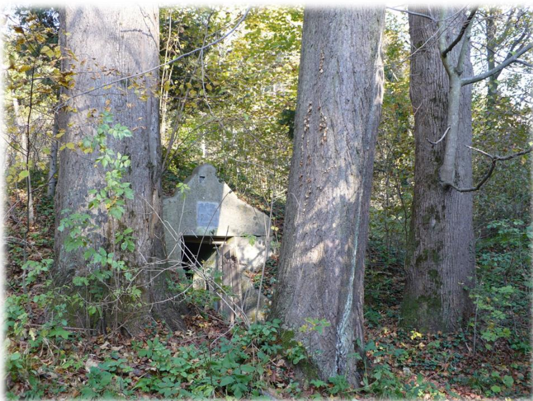
Fot. Ruiny zabudowań wodociągu doprowadzającego wodę do zamku Potockich. w Łańcucie, wybudowany w 1893 r. Leśnictwo Trnawka, oddz. 41Ai.
