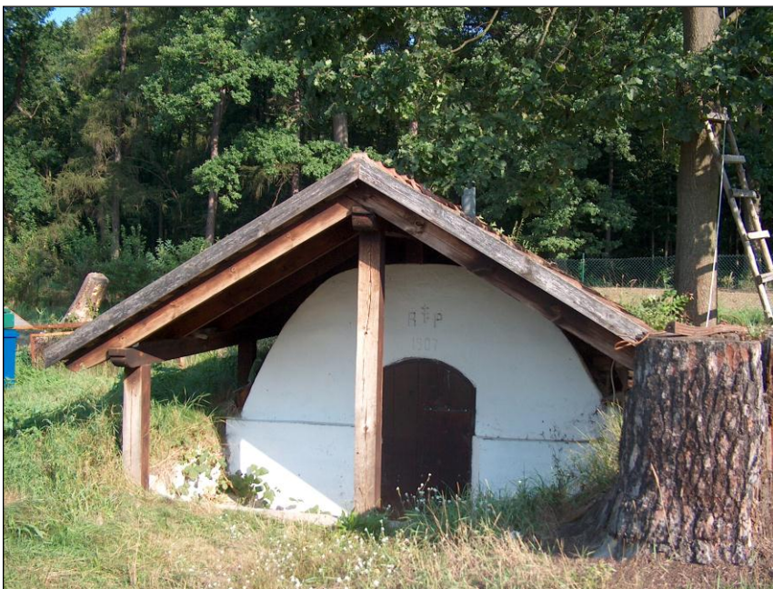
Fot. nr 19. Piwnica z 1907 r. z herbem właściciela ówczesnych dóbr hr. Alfreda Potockiego (oddz. 129 m obrębu Głogów).
