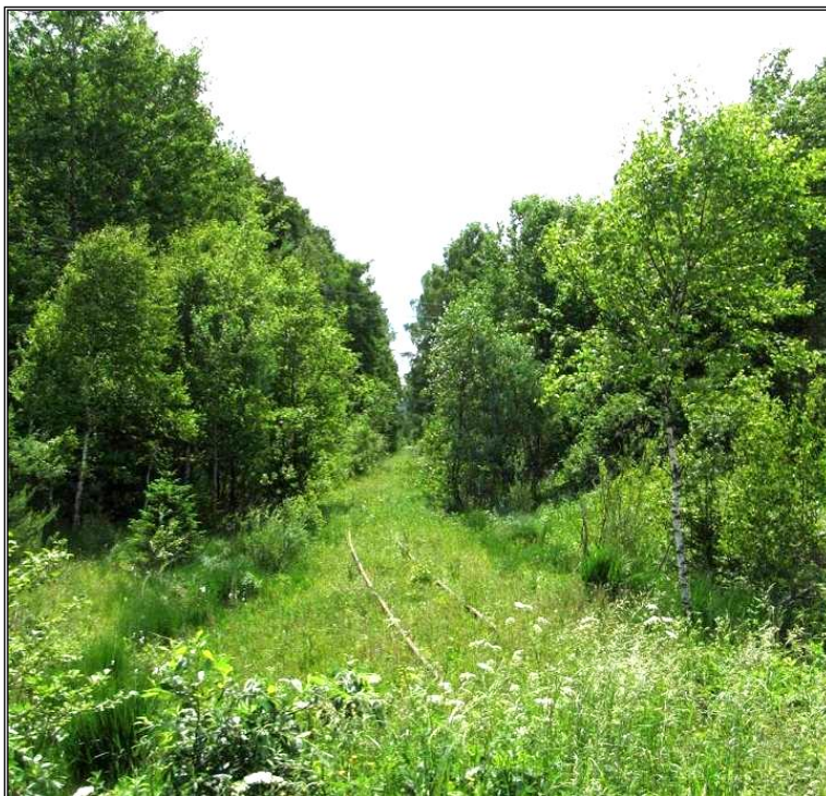
Fot. Nasyp kolejowy nieczynnej kolejki wąskotorowej (leśnictwo Kalnica).
