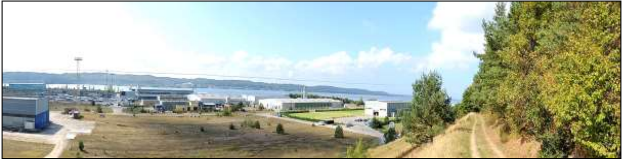
Fot. 4 Widok na oddz. 50k (I-ctwo Lisewo) na stromej wysoczyźnie zachodniego brzegu Jeziora Żarnowieckiego (w głębi).
