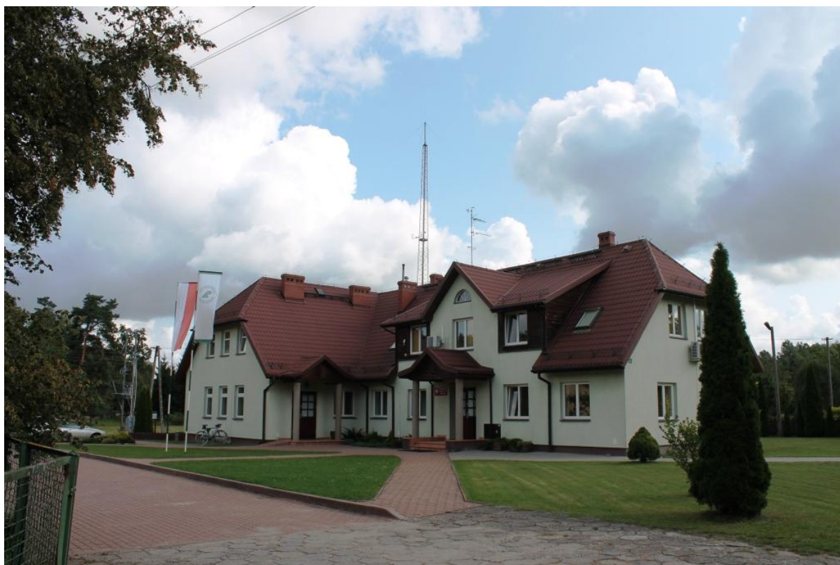
Ryc. 4. Siedziba Nadleśnictwa Nowogród w Dębnikach (fot. M. Augustynowicz)
