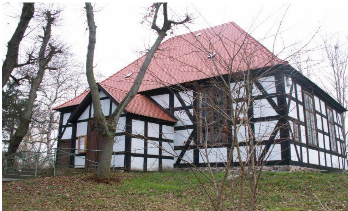
Ryc. 70. Kościół z tzw. pruskiego muru (Fot. z gminnego portalu internetowego).
